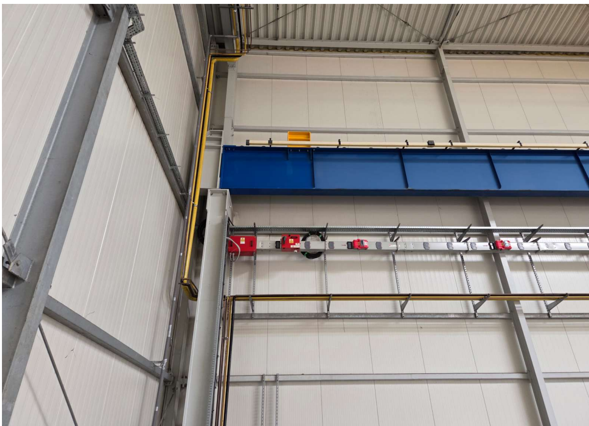
Fot. 2. Zdjęcie belki podsuwnicowej wraz z odbojem.
